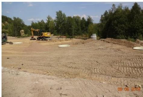
Einbau der Beton-Flachlysimeter („Beton-Schüsseln“) im Testfeld, um das eindringende Sickerwasser zu erfassen (PP4 SAXONIA Standortentwicklungs- und -verwaltungsgesellschaft mbH)
